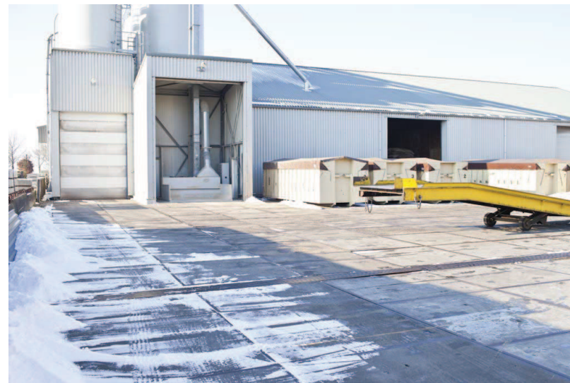
Stortput met silo's
